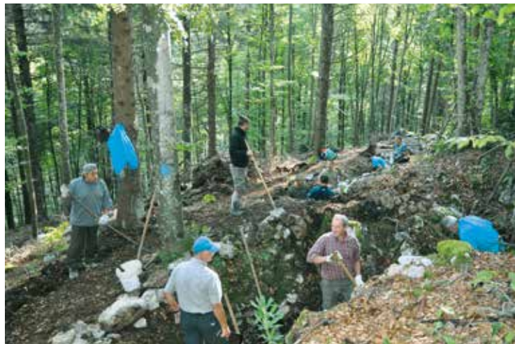
Gli alpini bresciani impegnati nei lavori di ripristino.
